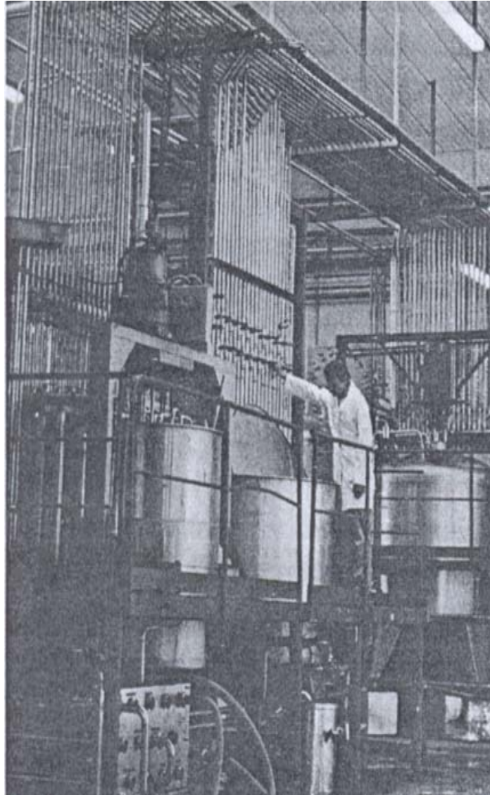
ภาพที่ 2.31 การผสมส่วนผสมของ flavoring material จาก compounding bay ที่มา : Reineccius (1994)
