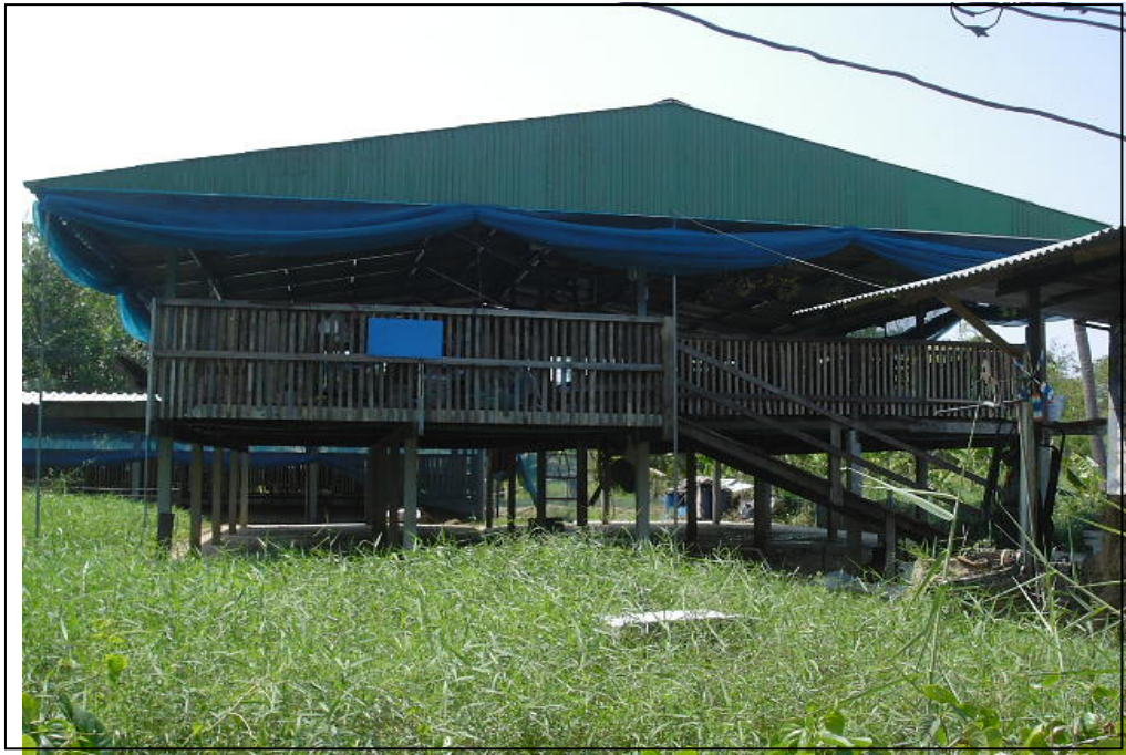
ภาพที่ 4.5 ลักษณะโรงเรือนแพะที่ยกพื้นสูง
