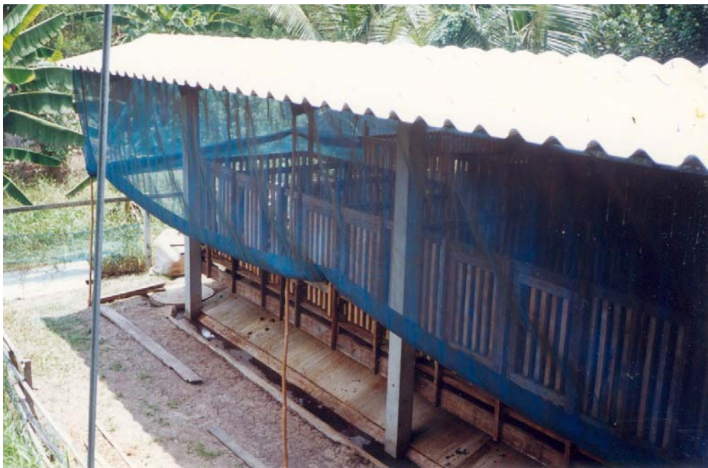
ภาพที่ 4.6 ลักษณะโรงเรือนแพะที่มีมุ้งตาข่ายยกขึ้นลงได้
