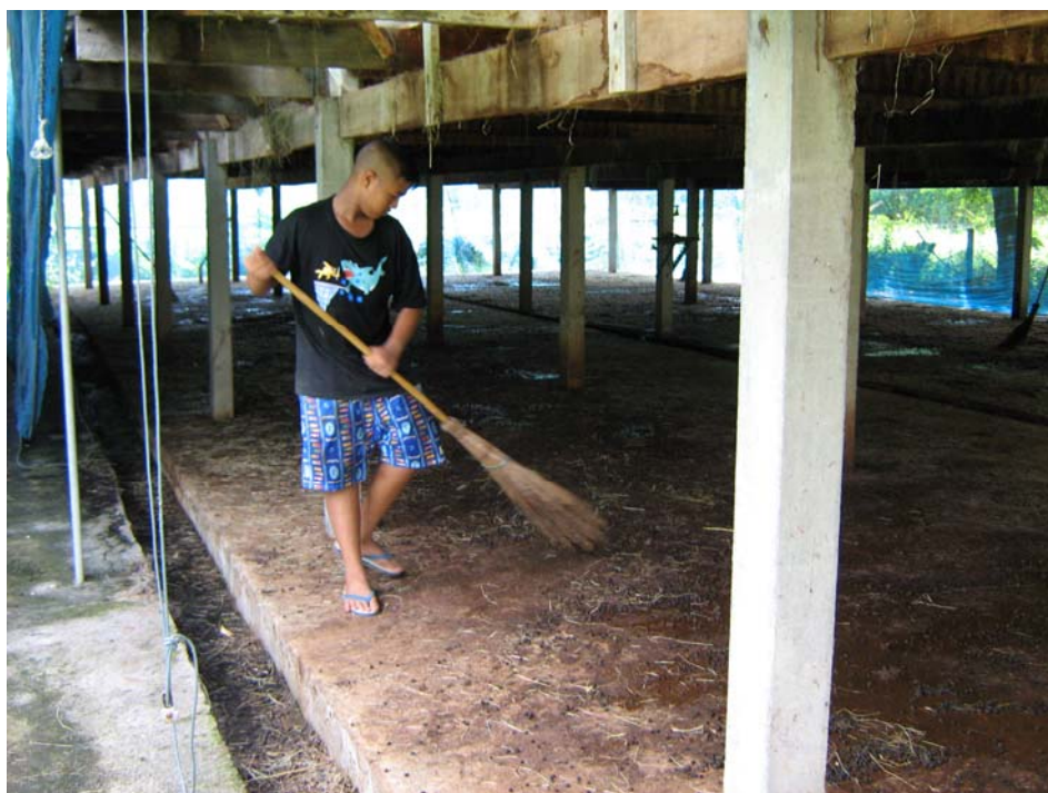
ภาพที่ 4.11 โรงเรือนยกพื้นสูงช่วยให้การทำความสะอาดพื้นโรงเรือนทำได้สะดวก
