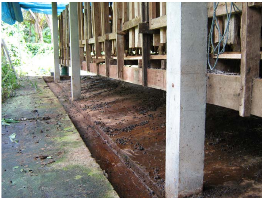
ภาพที่ 4.10 พื้นโรงเรือนควรเทให้ลาดเอียงเพื่อให้สิ่งปฏิกูลต่างไหลลงท่อระบายได้
