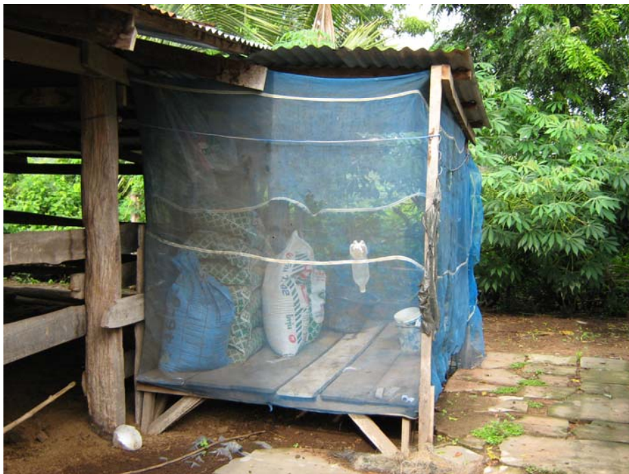
ภาพที่ 4.22 การสร้างเพิงใช้เก็บอาหารโดยมีมุ้งป้องกันนก หนู และแมลงเข้าทำความเสียหาย
