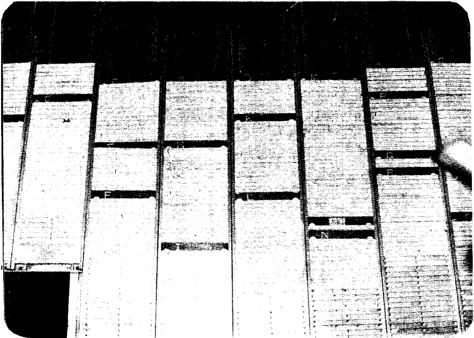
รูปที่ 3-1 RACK SLIP ใน ROOM RACK
